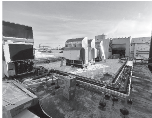
本発明による冷媒用多層管設置工事施工例
