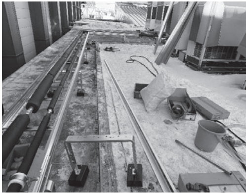
本発明による冷媒用多層管設置工事施工例
