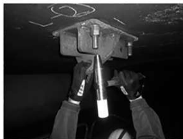
トンネル内附属物点検
