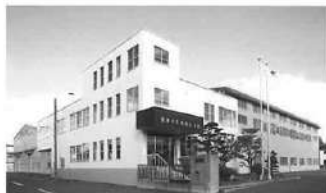
■本社・札幌工場
