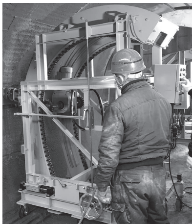
水路トンネルへ応用した左官アシスト均し機
