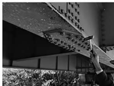
橋梁高張力ボルト点検
