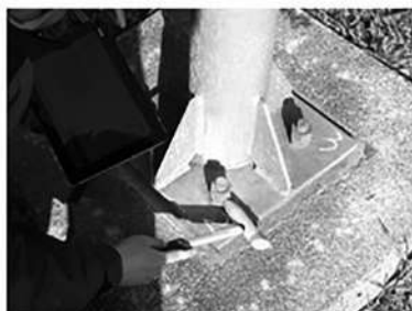
標識等の道路附属物点検
